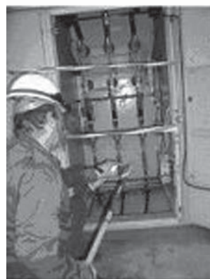
Fig. 2.64 Limpieza en seco mediante aspiración
