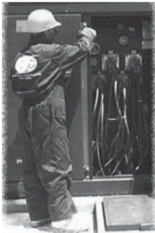
Fig. 2.1 Mantenimiento a transformadores.
