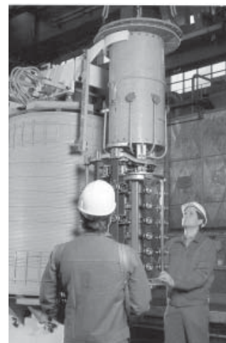
Fig. 1.12 Mantenimiento del transformador
