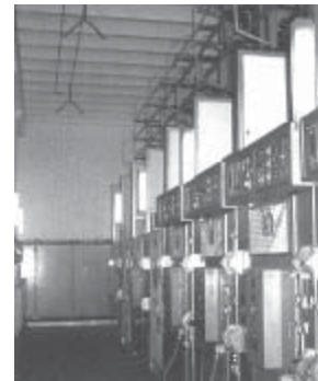
Fig.1.299 Interior de una estación transformadora construida con celdas convencionales
